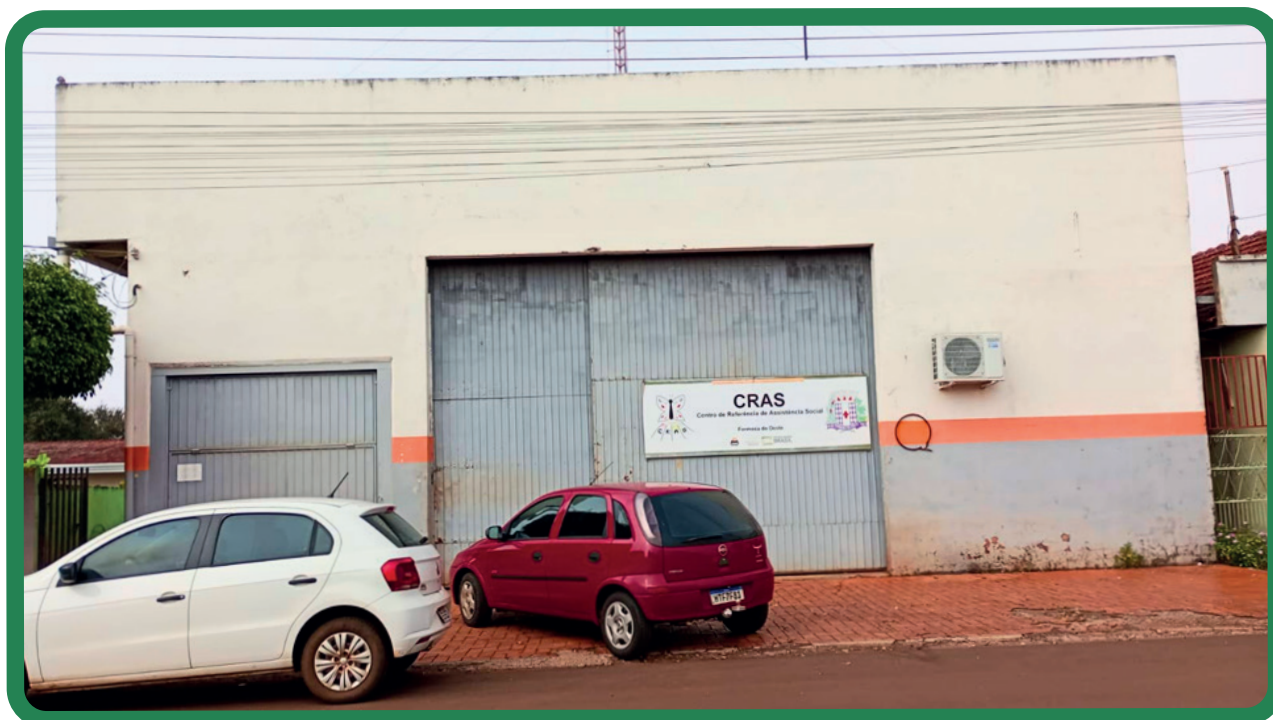
Figura 3 - Centro de Referência da Assistência Social de Formosa do Oeste-PR
